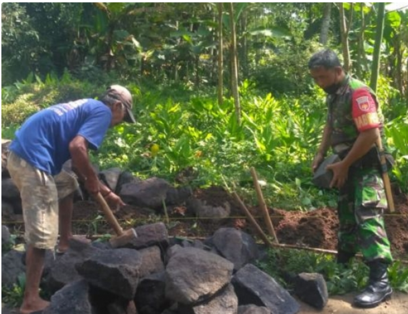
Bersama Warga Duren, Serka Yarmo bantu proses pembuatan Talut jalan
